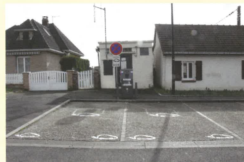
Installation de deux bornes de recharge pour véhicules électriques rue du 11 novembre (photo) et sur le parking de la gare
