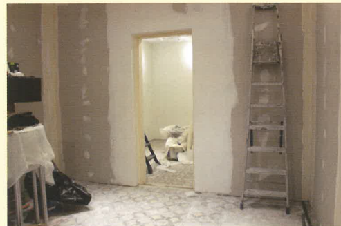
Réfection de locaux municipaux par les services techniques : musée des Amis du Vieux Corbie (photo) et club-house de Corbie Pétanque
