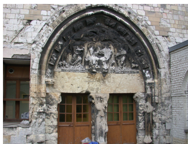
Le portail de l'ancienne église Saint-Etienne
