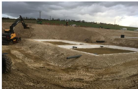
Ainsi, d'une part, rue du marais, un poste de refoulement, un bassin de stockage restitution et un local technique ont été construits à proximité de la lagune actuelle (conservée pour accueillir les eaux de pluie en cas de déversement pluvieux supérieurs à la décennale). D'autre part, rue de Sully-Laurette, les travaux ont consisté à créer un filtre planté de roseaux.
